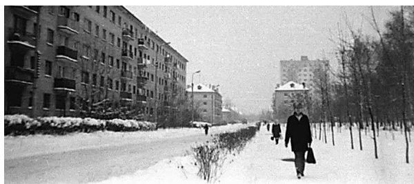
1976, г. Троицк, ул. Центральная, дом 10
